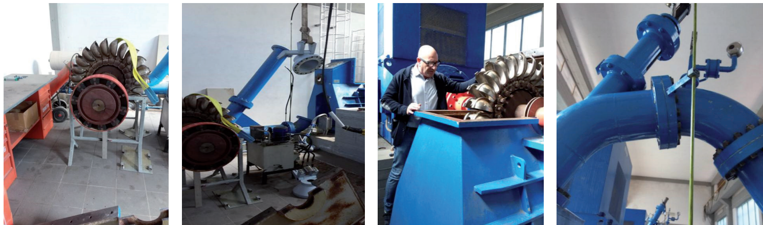
Fig.5: Fasi lavorative degli interventi
