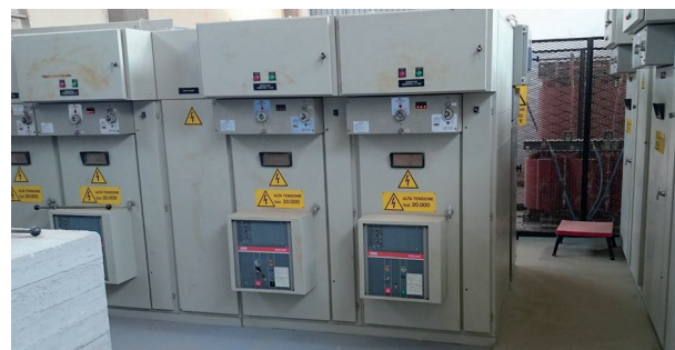
Fig. 11: Centrale idroelettrica Agghiastro. Particolare dei quadri di Media tensione a 20.000 V
