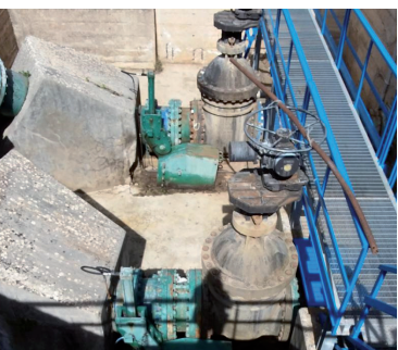
Fig.6: Sistema di by-pass idraulico
