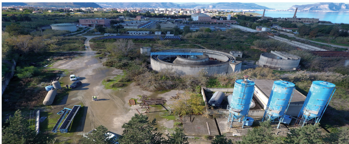
Ripresa aerea con drone, del sito incompleto da riconvertire. Sullo sfondo l'impianto di depurazione di Acqua dei Corsari del Comune di Palermo (440.000 A.E.)
