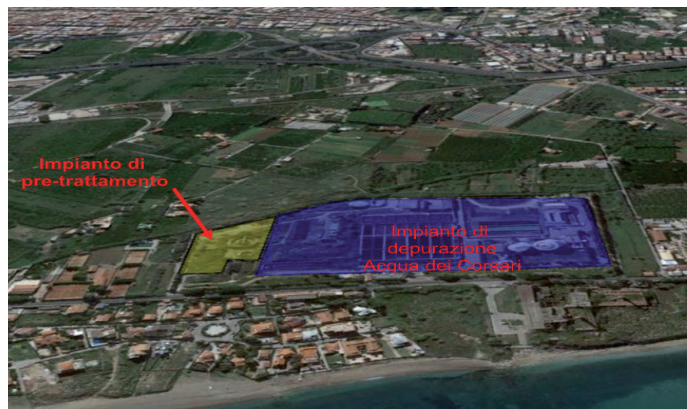
Vista aerea del sito dell'impianto di depurazione di Acqua dei Corsari del Comune di Palermo (440.000 A.E.); in giallo l'area interessata al progetto sezione pretrattamento percolato
