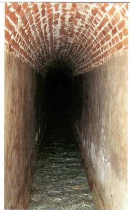
11-12. | Interno del cunicolo Gabriele, tratto di galleria con pavimentazione in mattoni a scacchiera bicromata; tratto di galleria che conduce alla sorgente Cuba, con parete in opus cementitium e volta in laterizi in creta.
